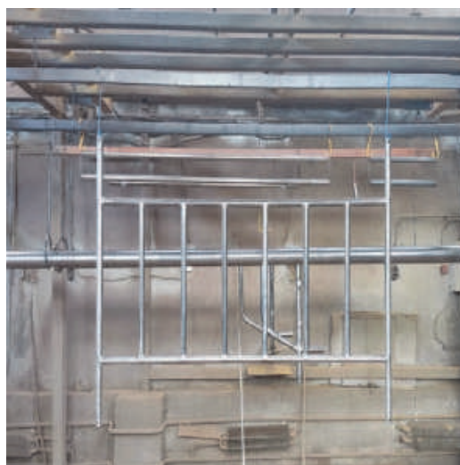
Рисунок 9 – Подготовка под покраску
