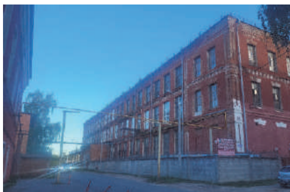
Рисунок 1 – Вид наружного надземного газопровода (пересекает дорогу общего пользования)
